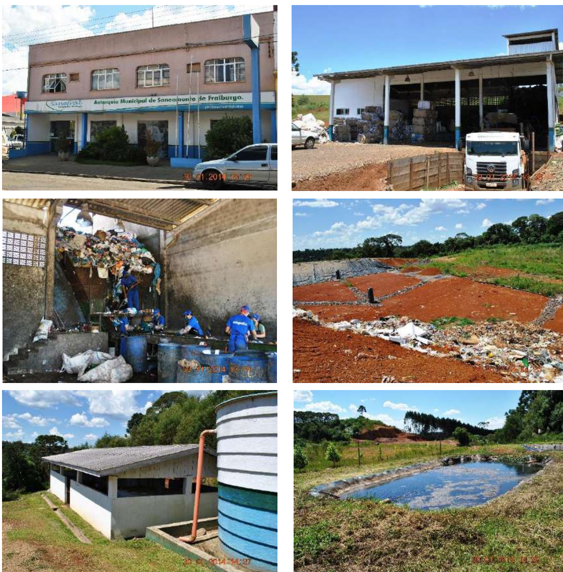
Figura 101 – Fotos da visita técnica
